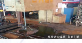
现场锯切情况 彭旭 | 摄
